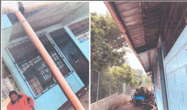
Foto 3: Vista de Canales y Bajadas de Agua Pluvial (BAP); las cuales la EORM prioriza sustituir y mejorar.
