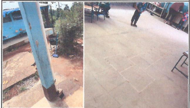
Foto 4: En el Modulo 2 de aulas, necesitan reparar 1 columna de pasillo y realizar mejoramiento de piso en aulas + pasillo.
